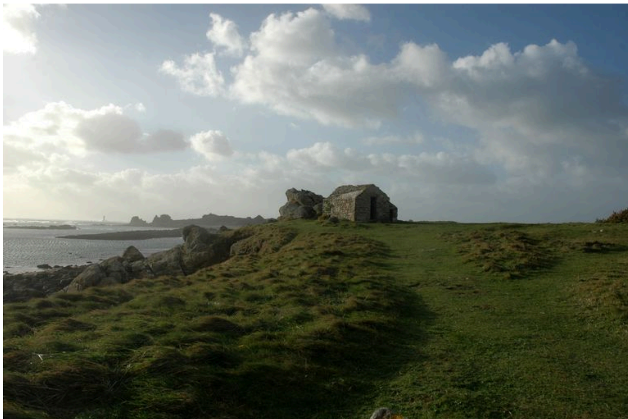
Vue de situation du corps de garde à l'extrémité de la pointe
