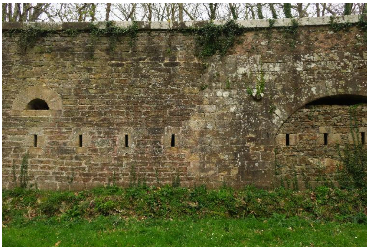
Le Palais, enceinte urbaine, galerie de contrescarpe, extrémité gauche, jonction entre les deux galeries.
