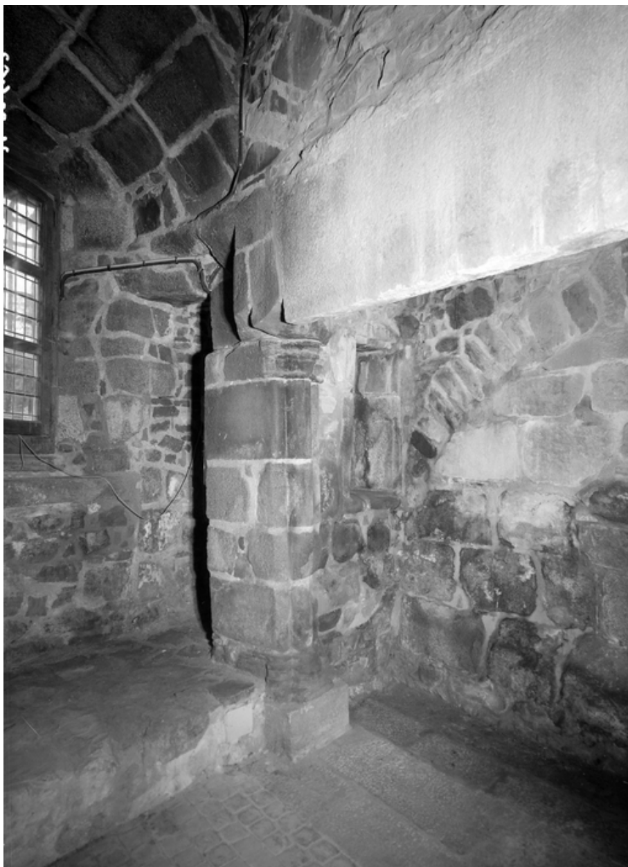
Vue de la cuisine : niche dans la cheminée (état en 1974)
