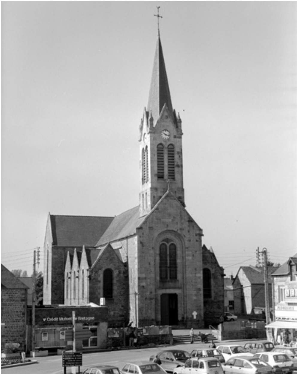
Élévation Nord : vue générale
