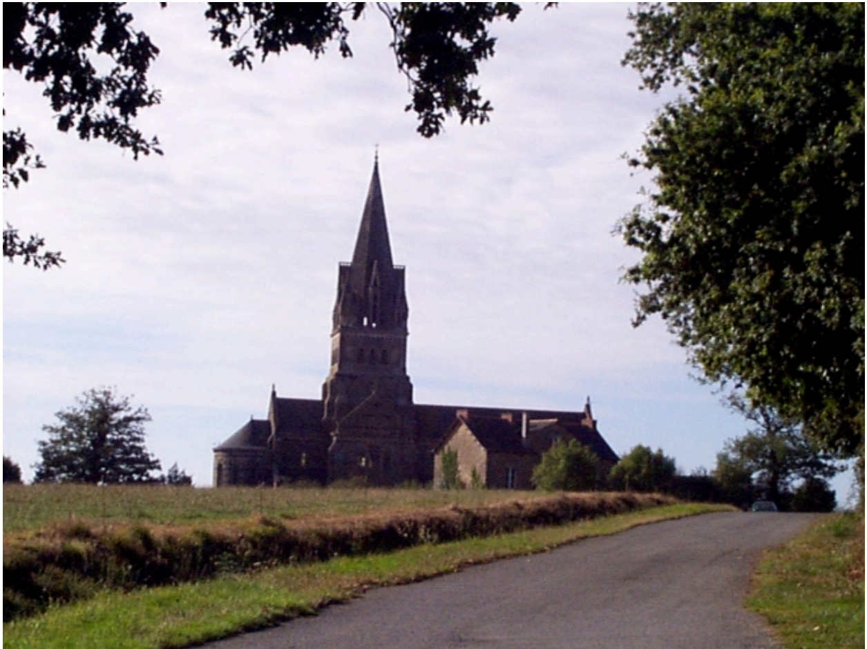
Vue de situation nord ; l'ancien presbytère au premier plan
