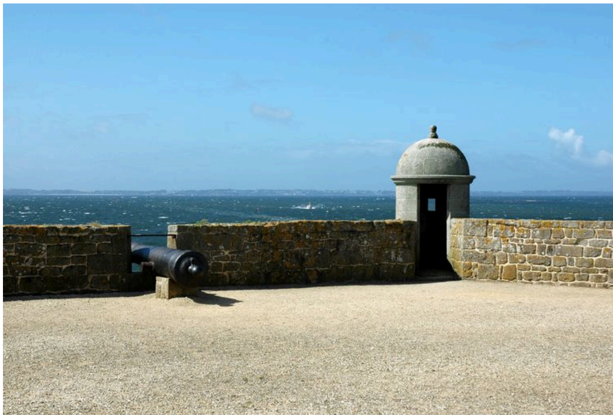
Vue de la citadelle de Port-Louis : embrasure plongeante et échauguette du bastion des Chambres
