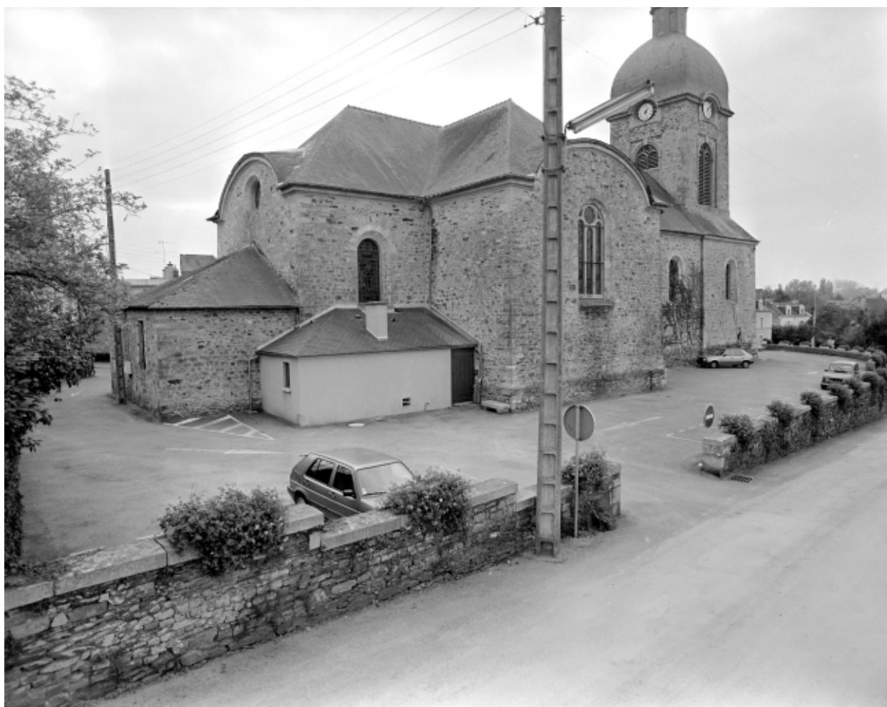
Vue générale nord est
