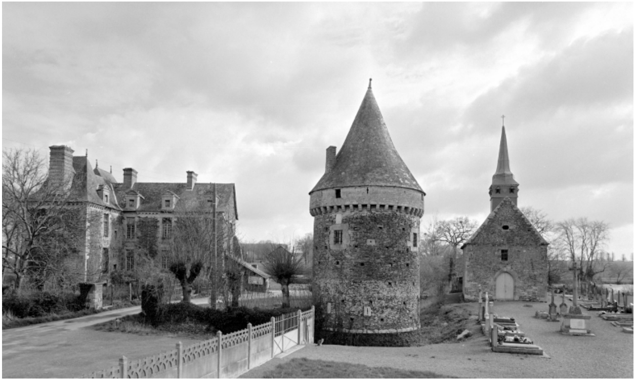
Elévation Ouest : vue de situation
