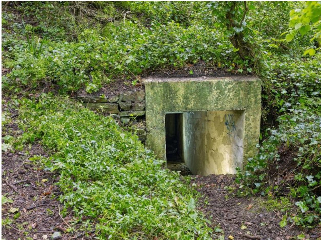
Vue de l'entrée du tunnel (l'entrée du tunnel - normalement de plain-pied - est partiellement murée par des parpaings)
