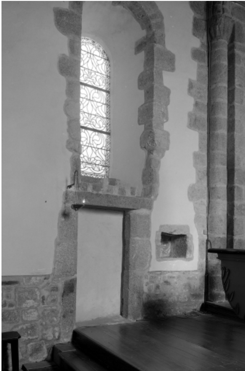
Intérieur, chœur, mur nord : vue générale.
