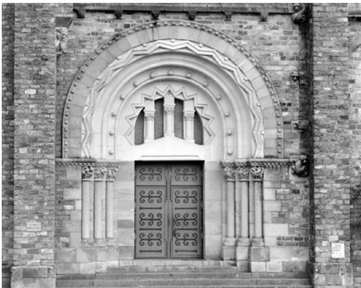
Elévation nord, porte : vue générale
