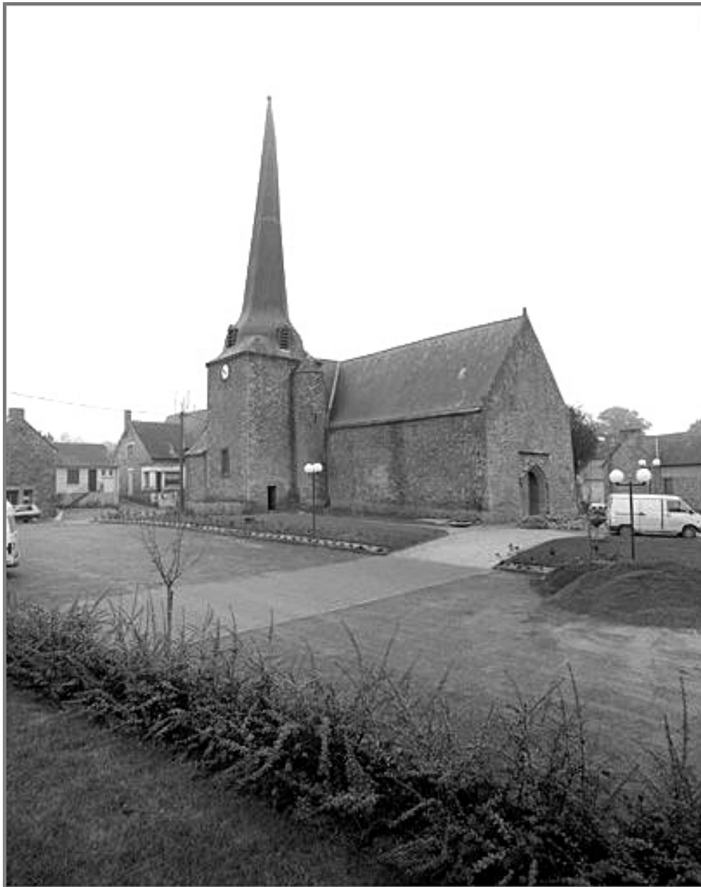
Élévation nord-ouest : vue générale avant restauration
