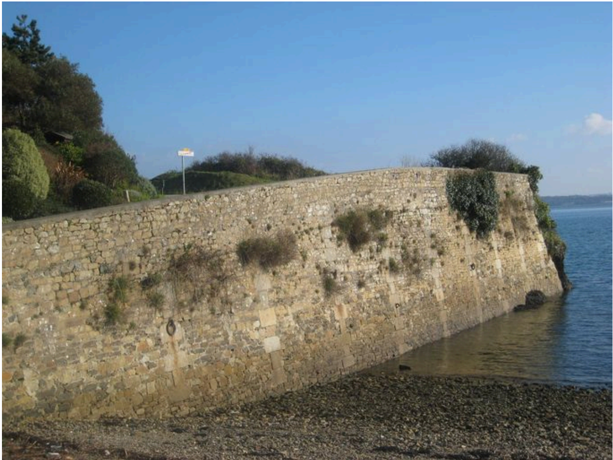
Vue générale du mur de soutènement de Pont-Scorff
