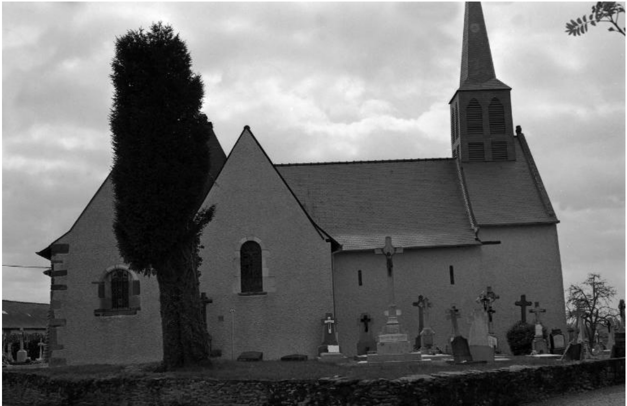
Eglise Saint-Melaine, façade nord
