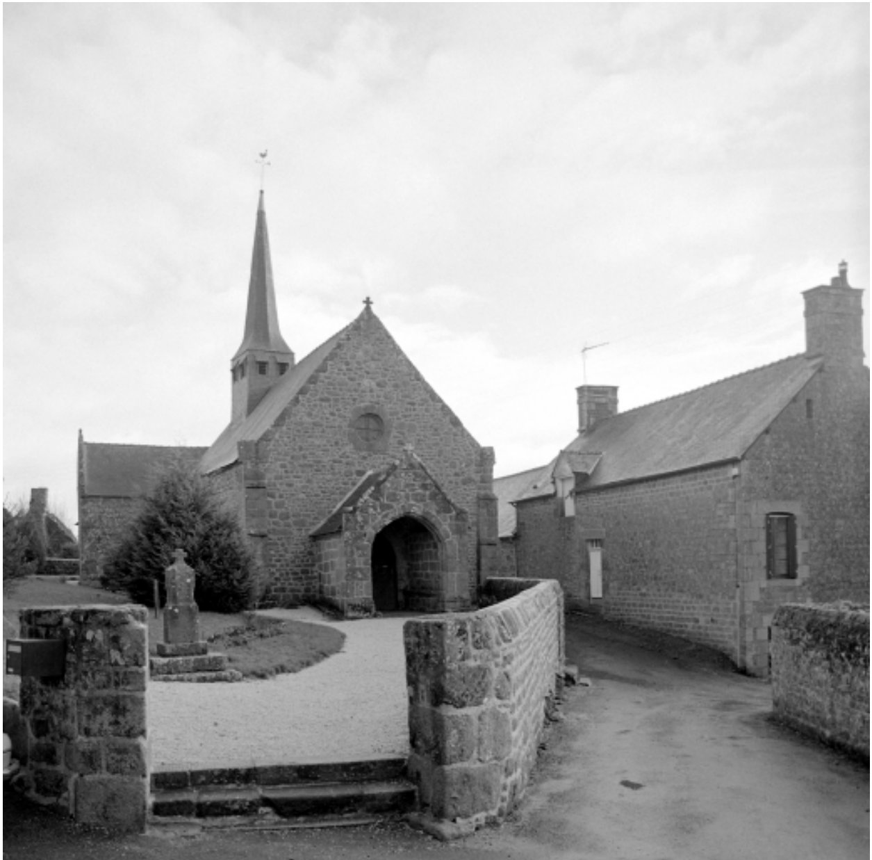
Elévation Nord-Ouest : vue générale
