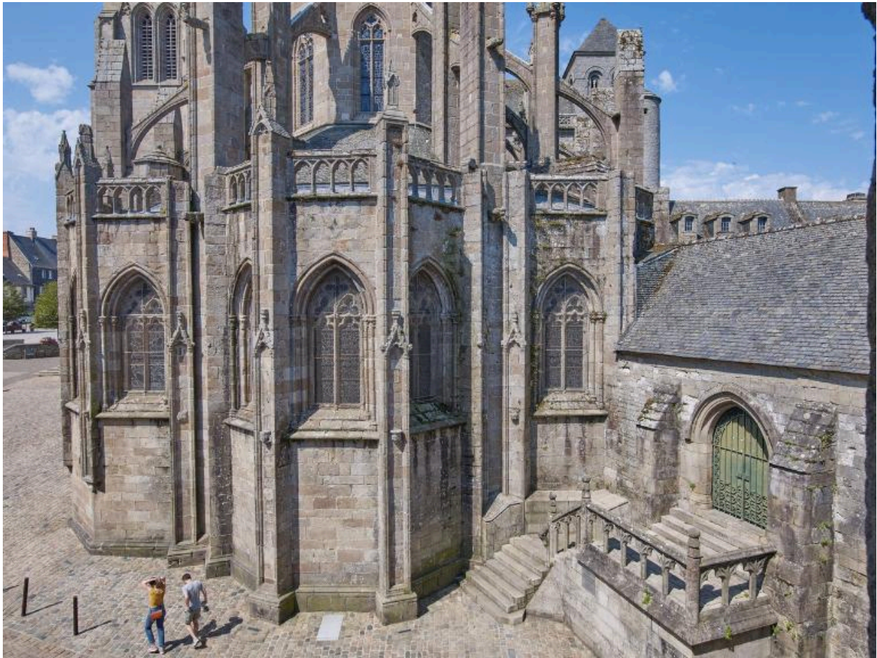
Vue générale du chevet et de l'entrée sud du cloître
