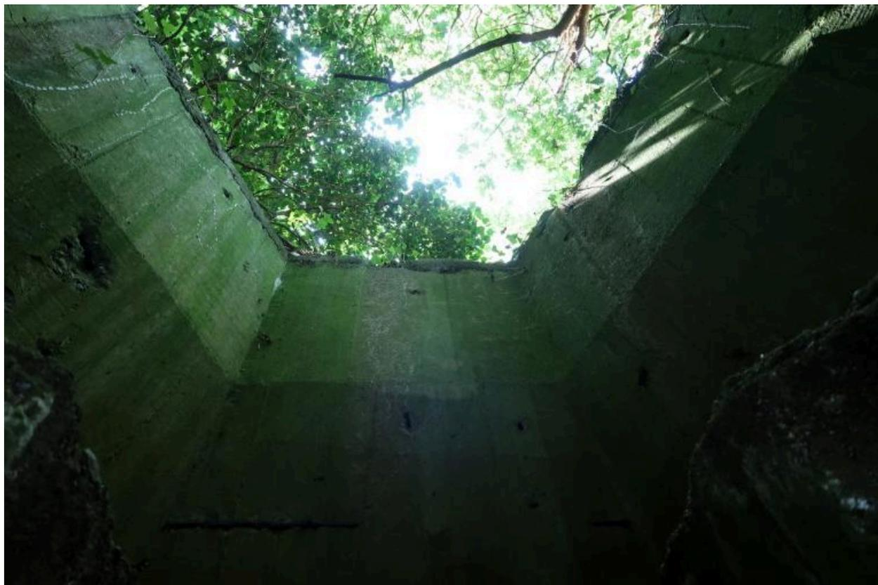
Vue de l'emplacement de la cloche blindée depuis l'intérieur. Ce bunker aurait dû être doté d'une cloche blindée de type 89P9
