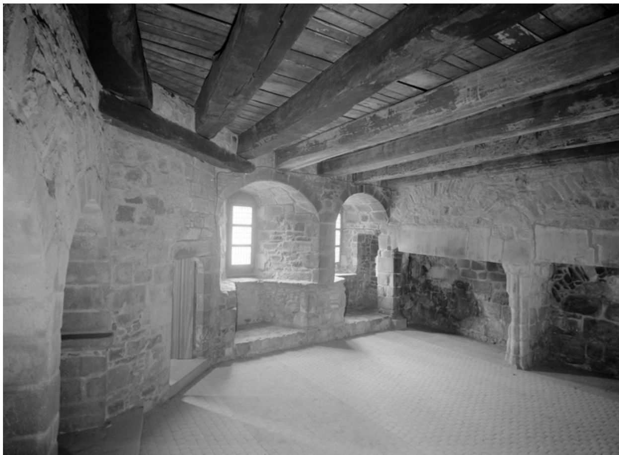
Vue de la cuisine depuis l'est (état en 1974). Au fond, les fenêtres et les cheminés géminés
