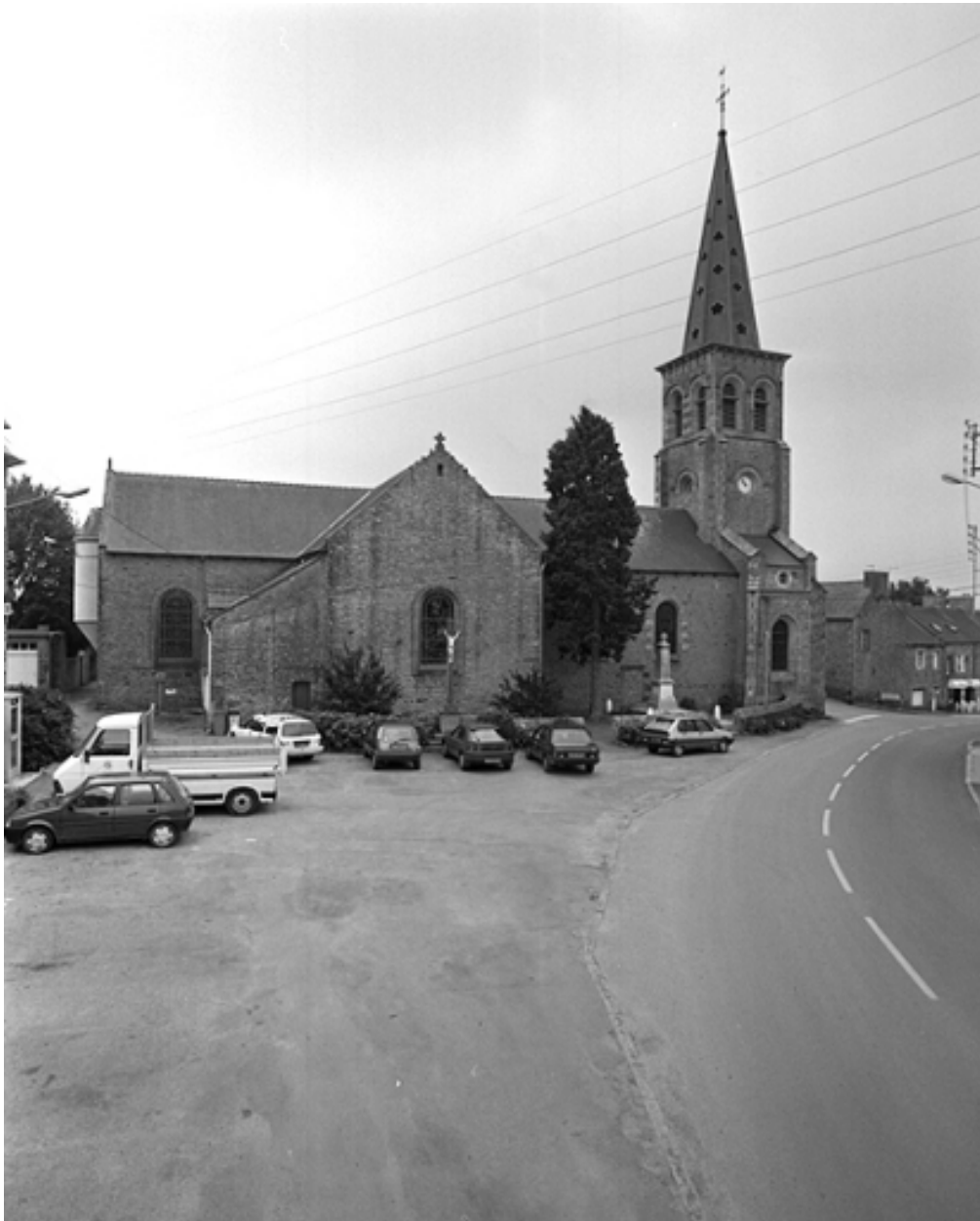
Vue générale nord
