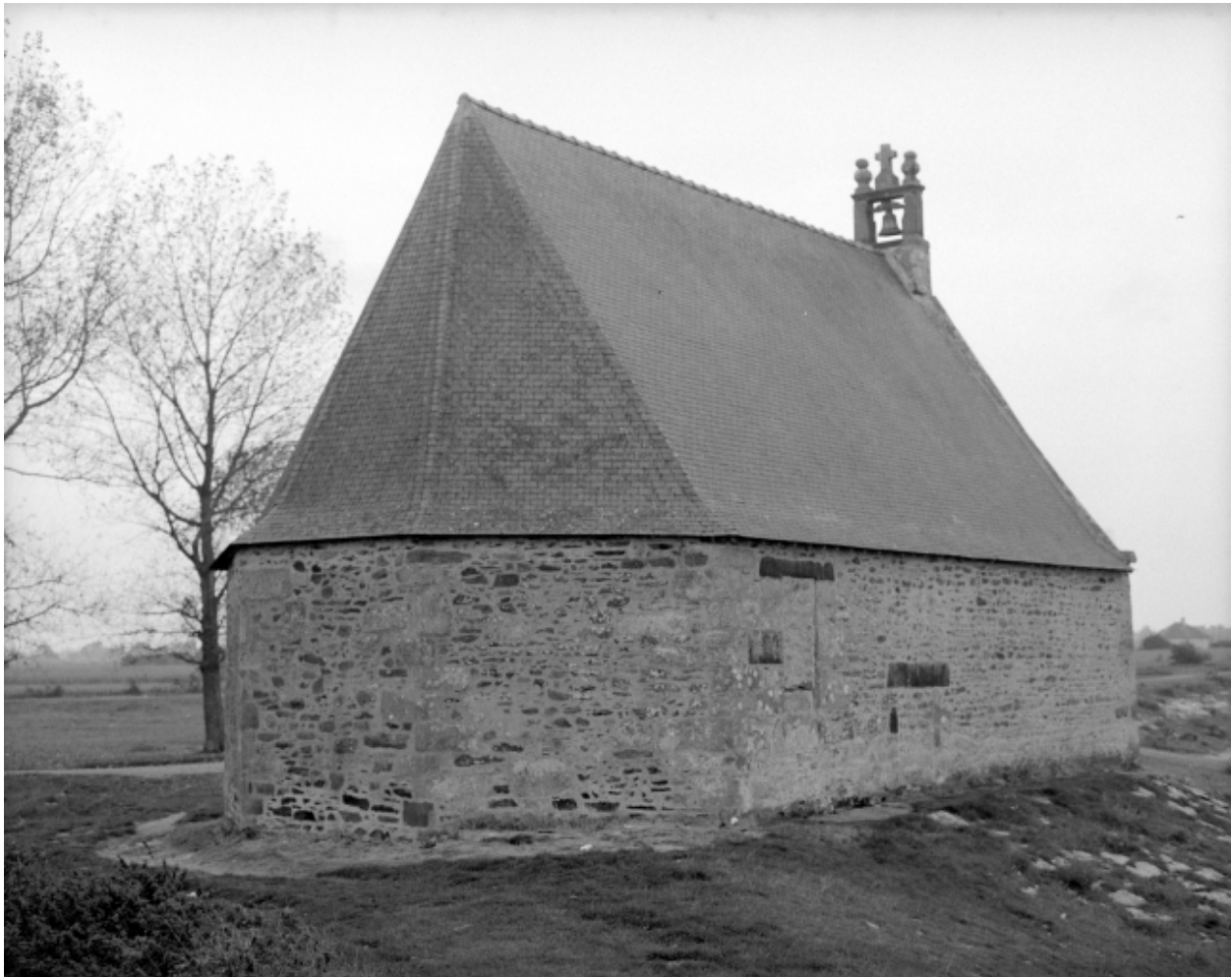
Élévation Nord-Est : vue générale
