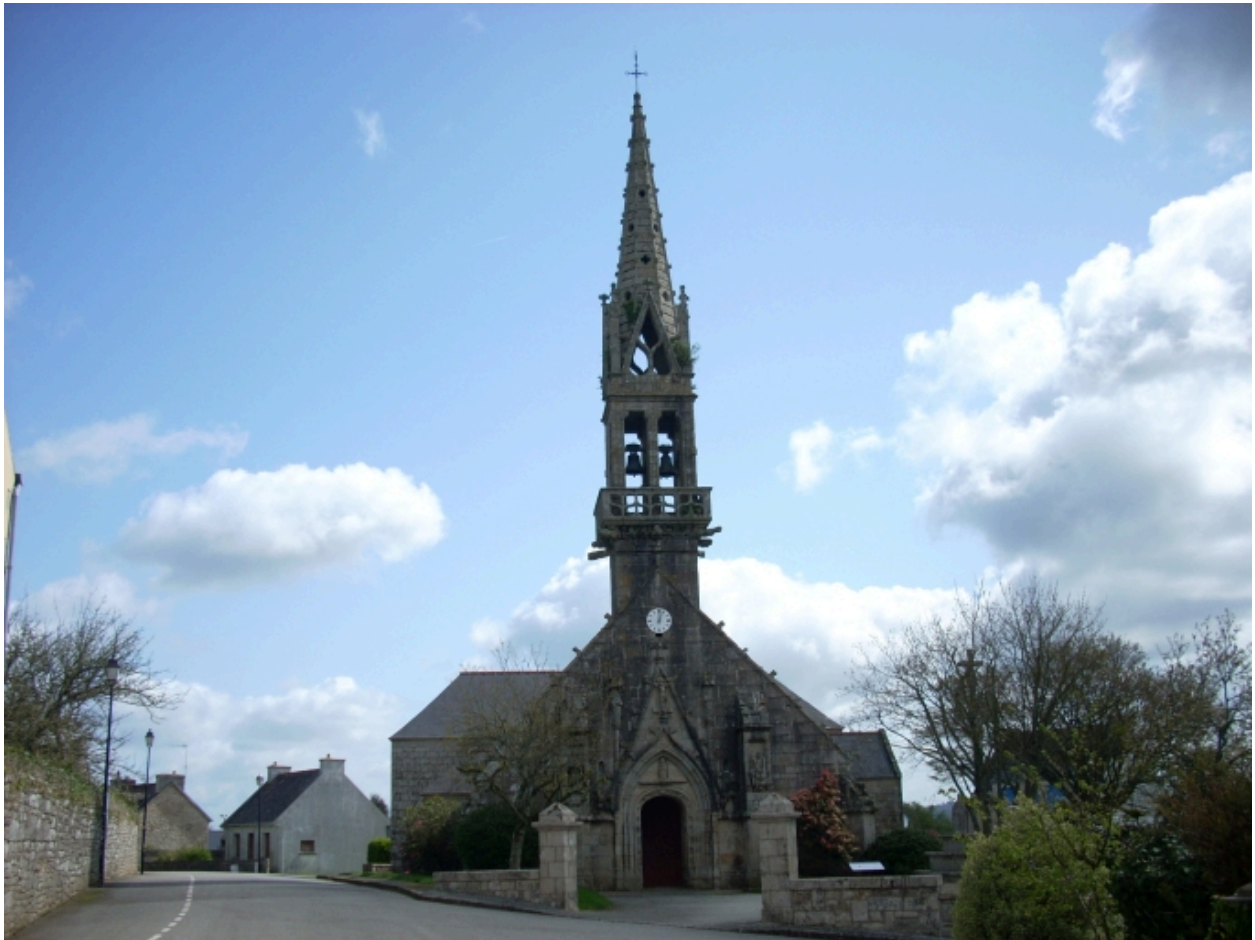
Langolen, église paroissiale Saint-Gunthiern : vue générale ouest
