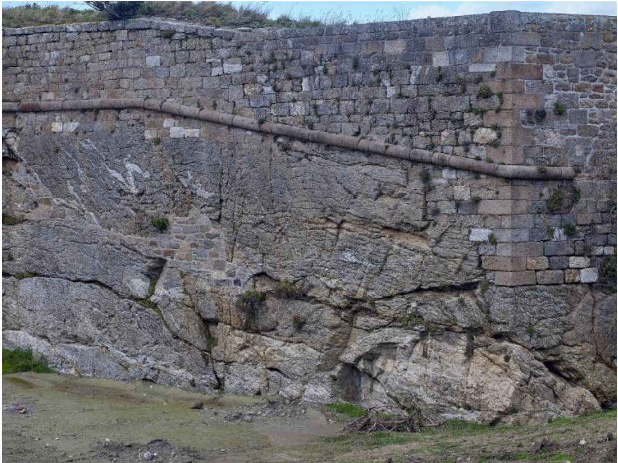
Vue générale depuis l'ouest-sud-ouest (couverture photographique du 22 janvier 2026). Fondée sur le rocher, cette partie du fort est montée en maçonnerie de pierre de taille
