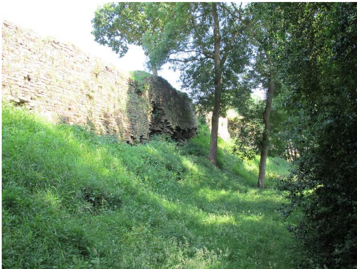
Château de Montafilan, enceinte ouest
