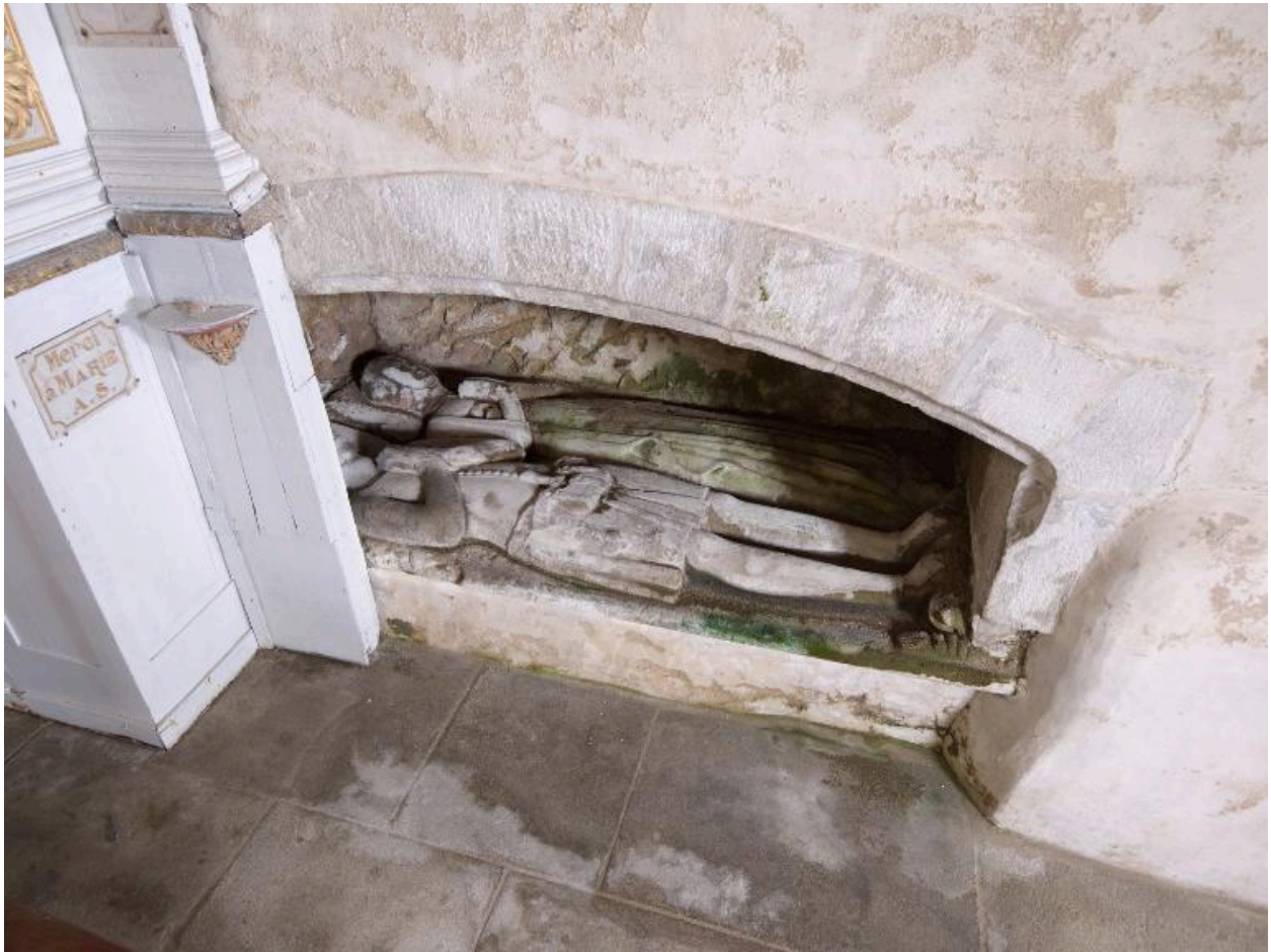
Chapelle nord. Enfeu et gisants des seigneurs de Roc'hélec'h à Langoat, fin du 14e siècle. Vue générale
