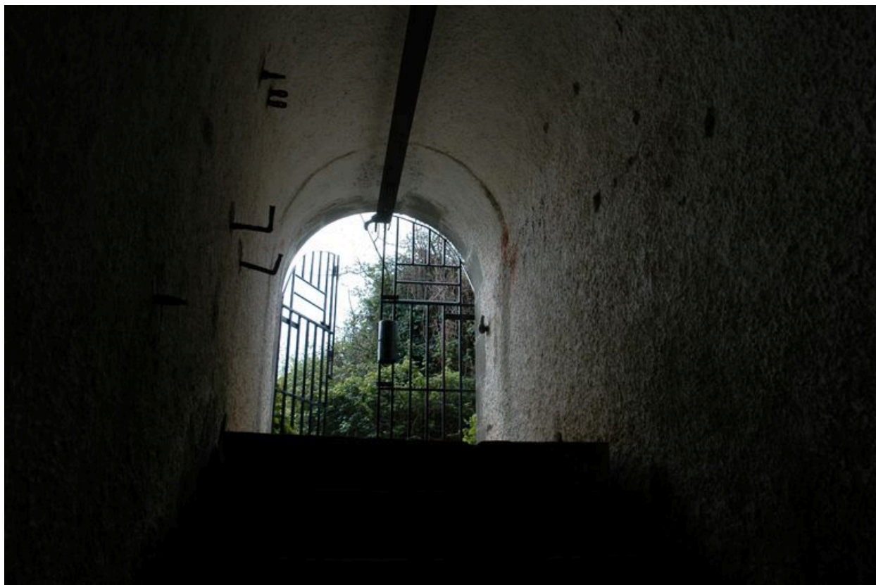
Vue de la pointe des Espagnols : escalier du magasin à poudre sous roc
