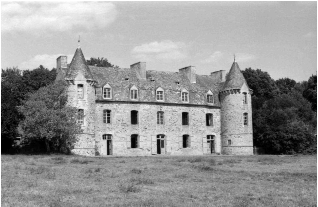
Vue générale du logis du château du Boyer
