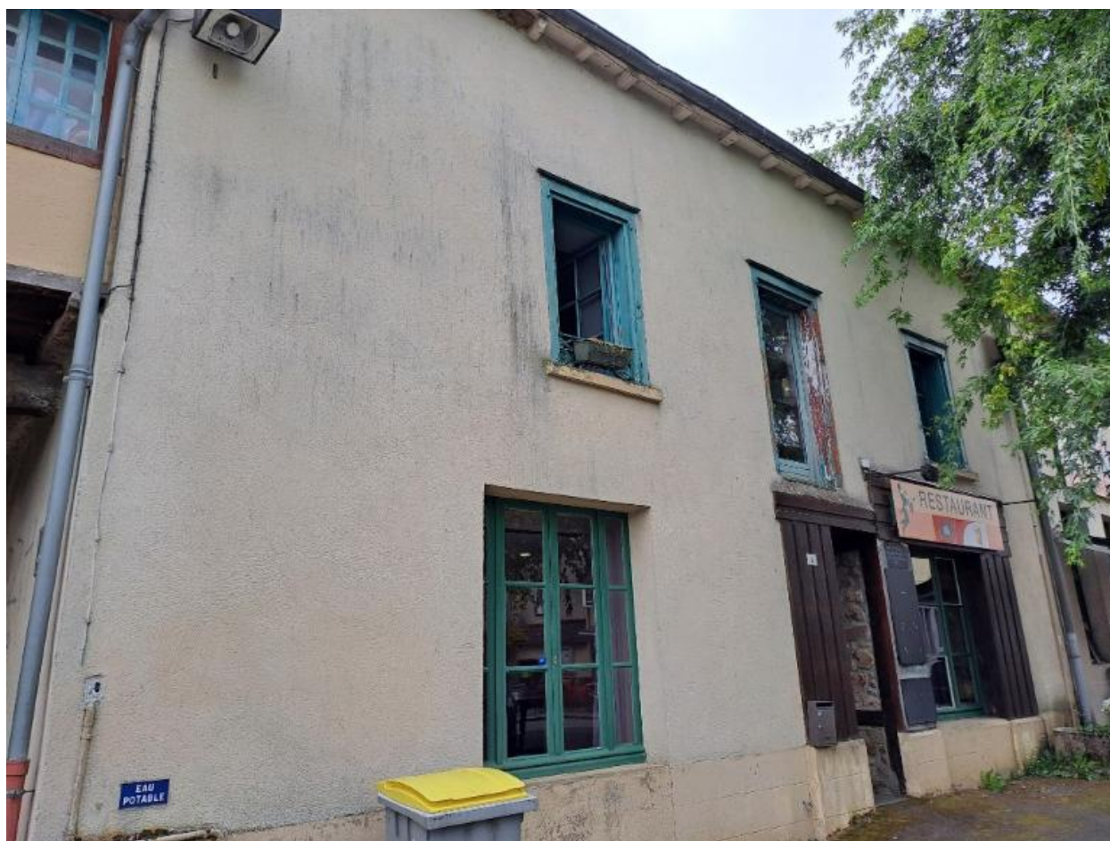
Vue de côté sur la façade Nord et ses ouvertures à encadrements de bois
