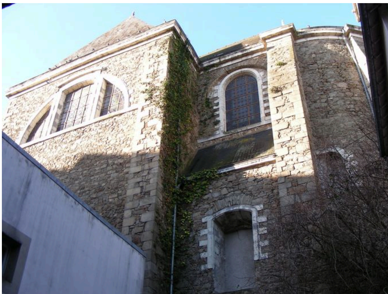
Choeur et transept, élévation latérale est.
