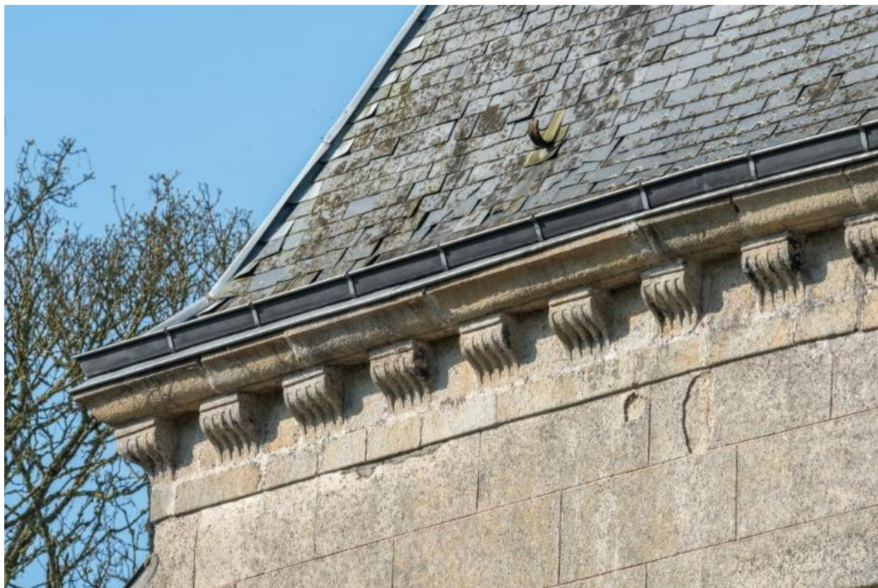
Façade est, détail des corniches
