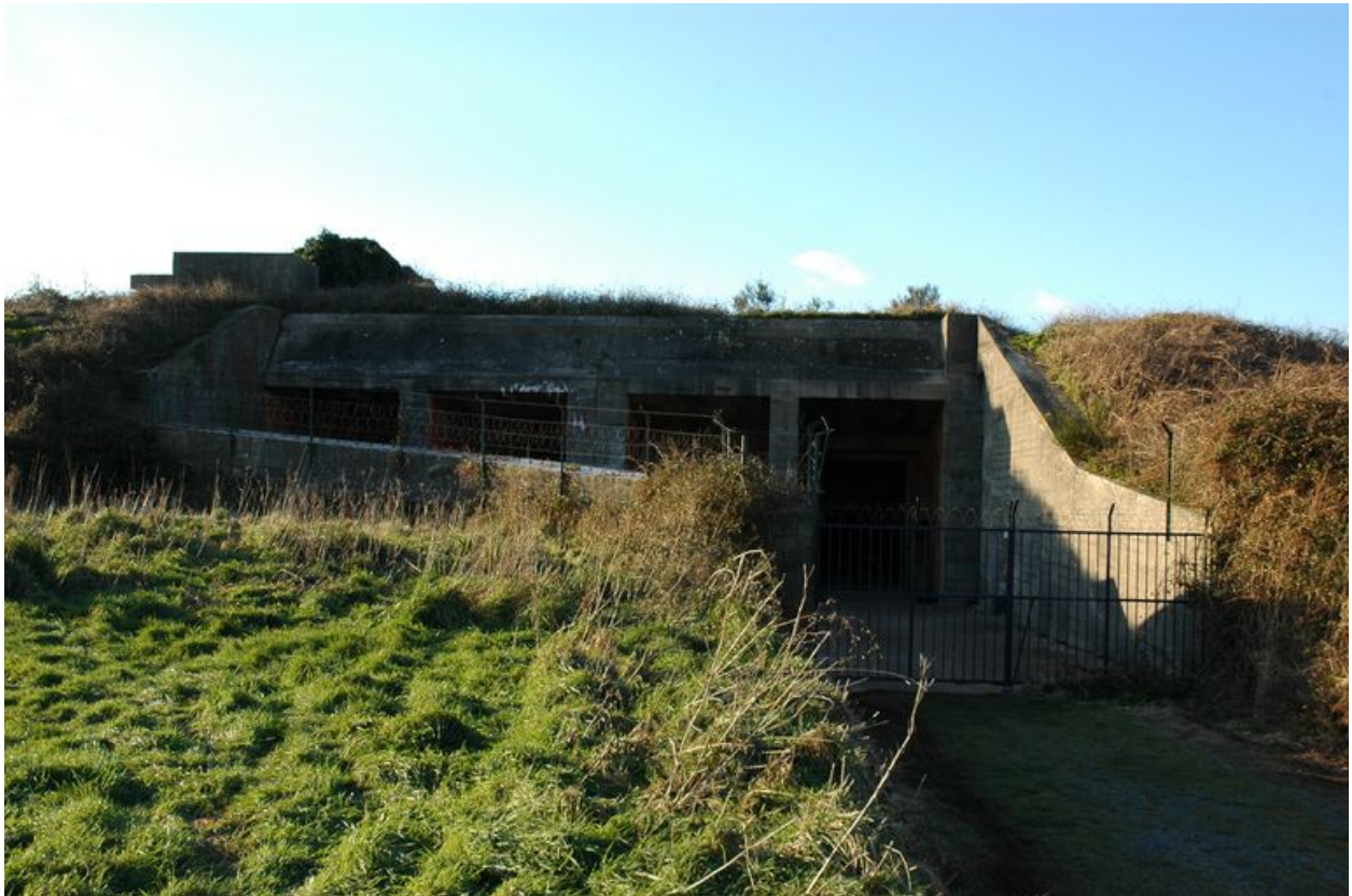
Vue générale du bunker-abri-garage depuis le sud-est (état en 2005)
