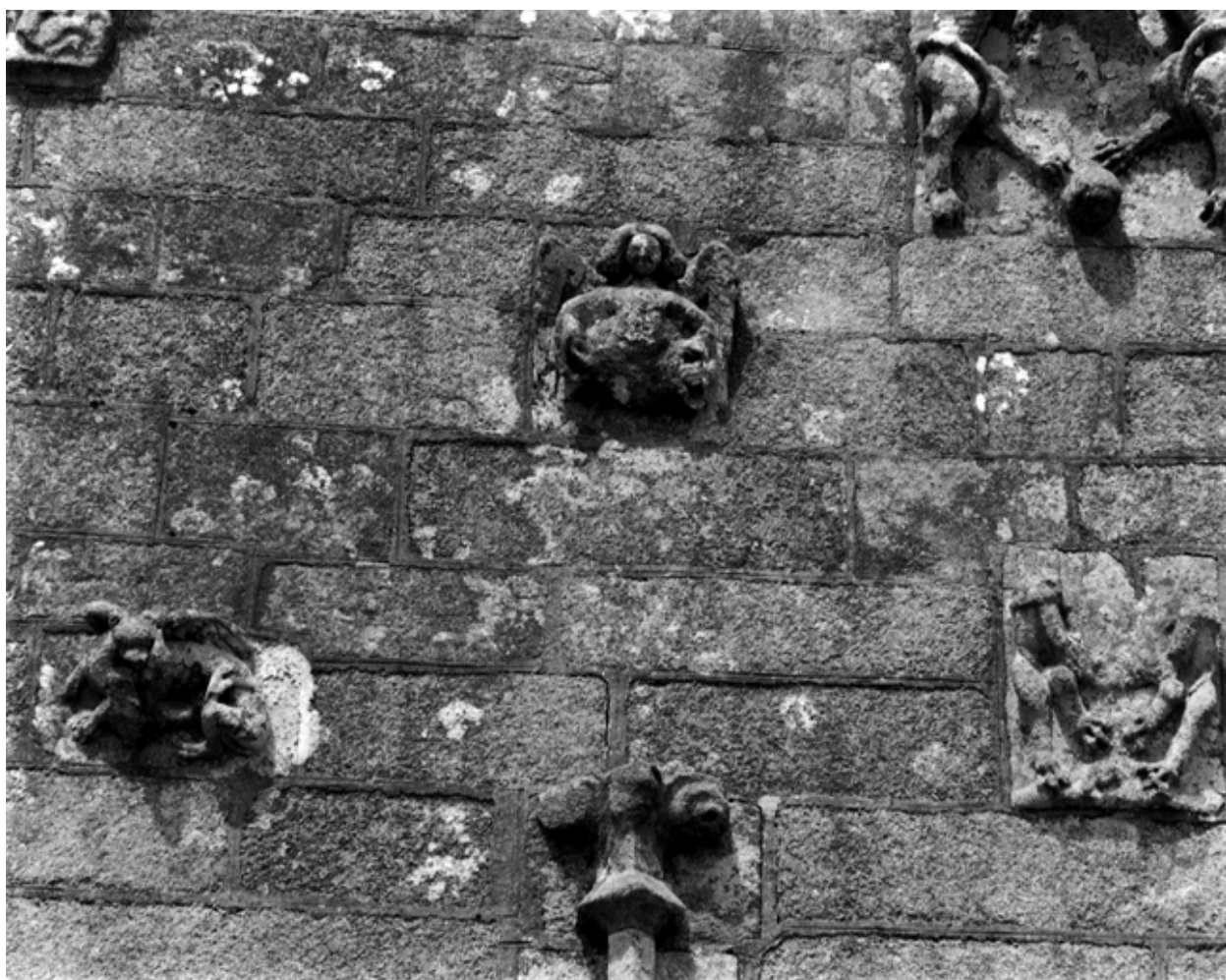
Pignon du porche sud, détail : reliefs surmontant le portail
