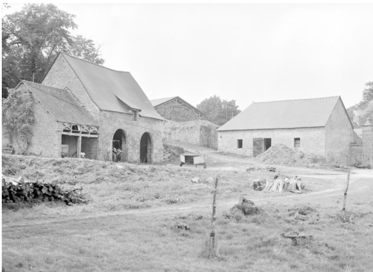
Communs et remise, vue générale sud-est.
