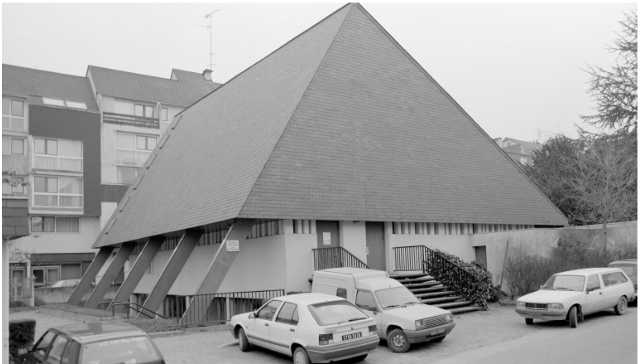
Elévation Nord : vue générale
