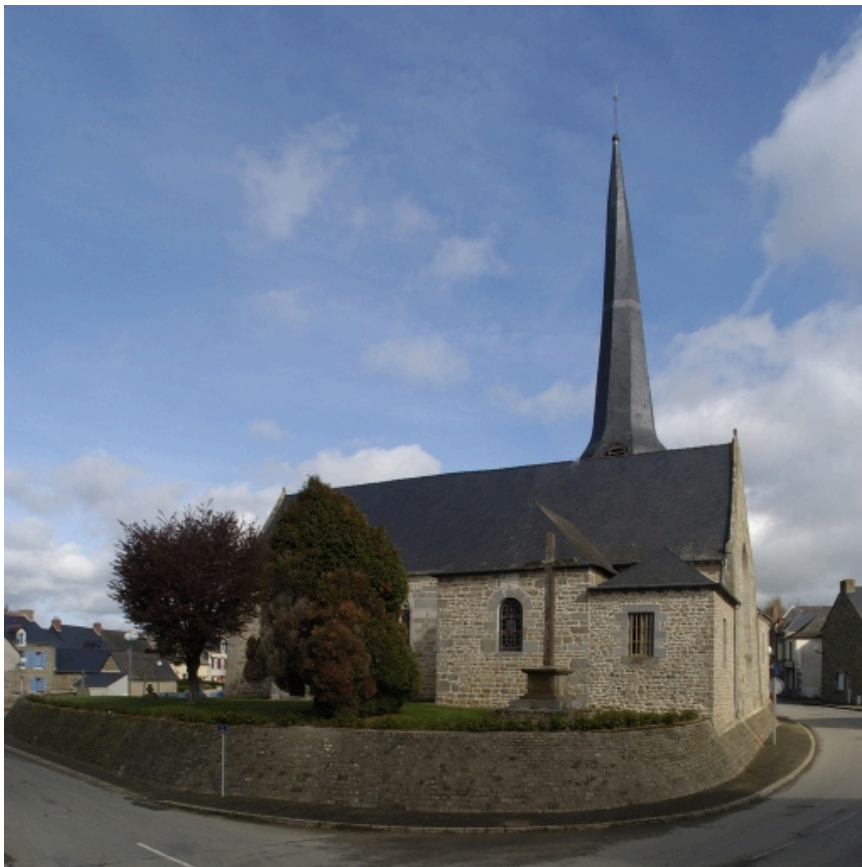
Vue générale sud
