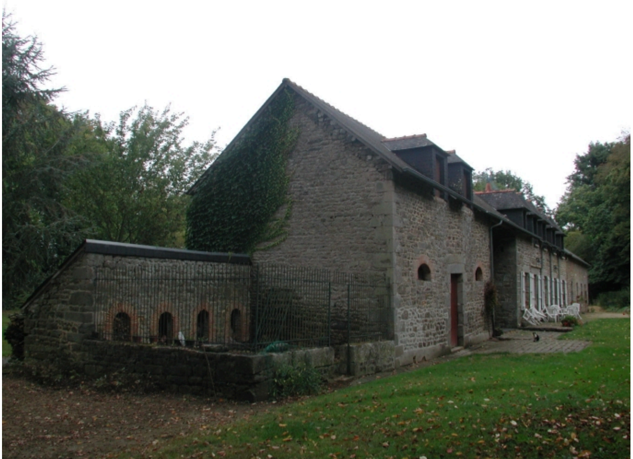
Ferme : vue d'ensemble depuis l'ouest ; chenil et écuries au 1er plan
