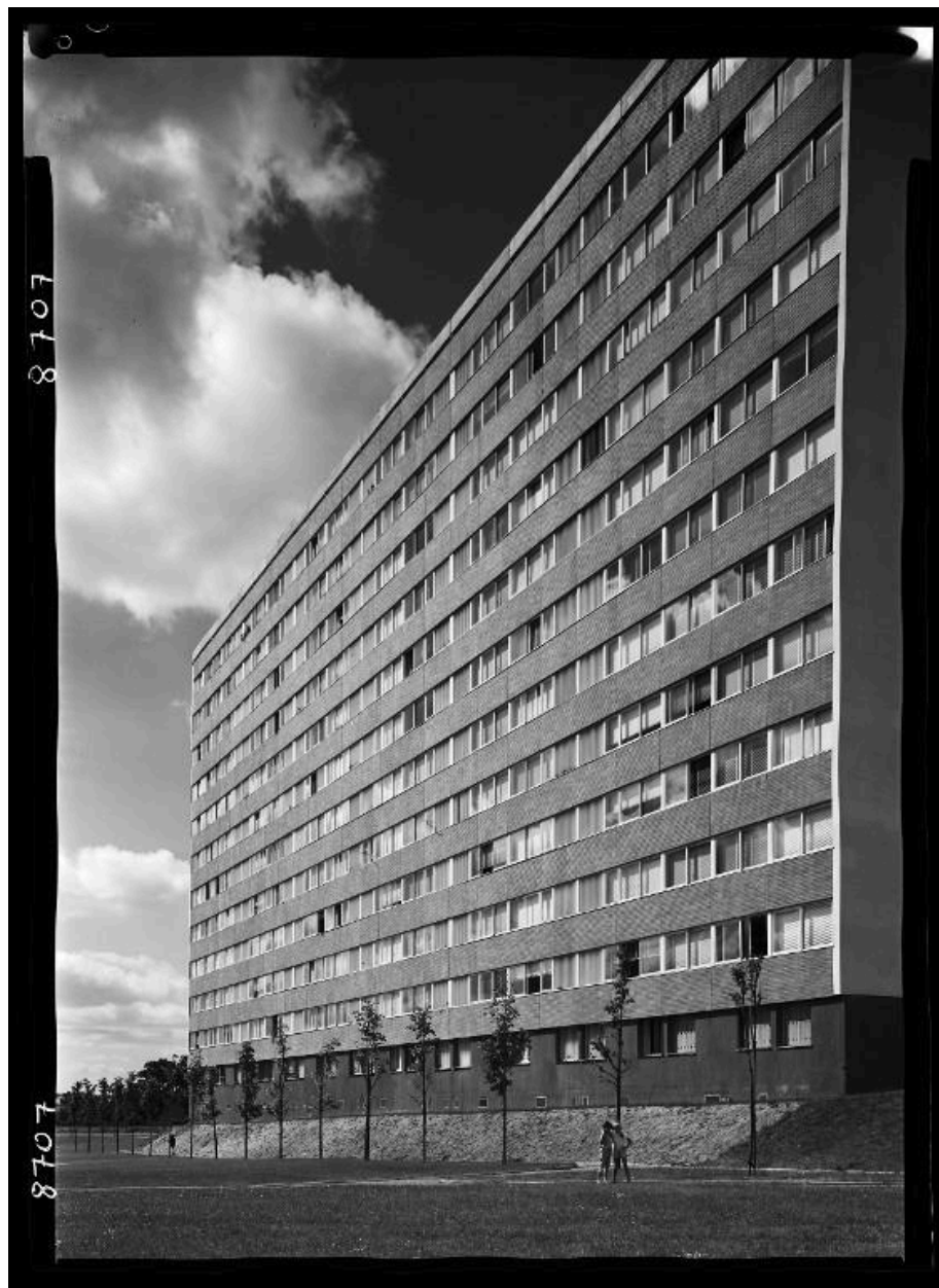
Vue générale du bâtiment B. 7 septembre 1964.
