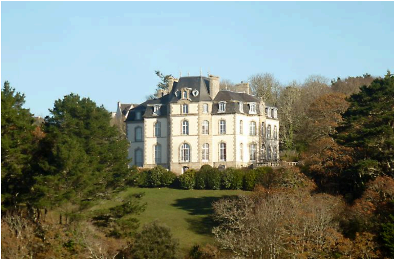
Vue générale ouest prise du pont d'Audierne. (2020)
