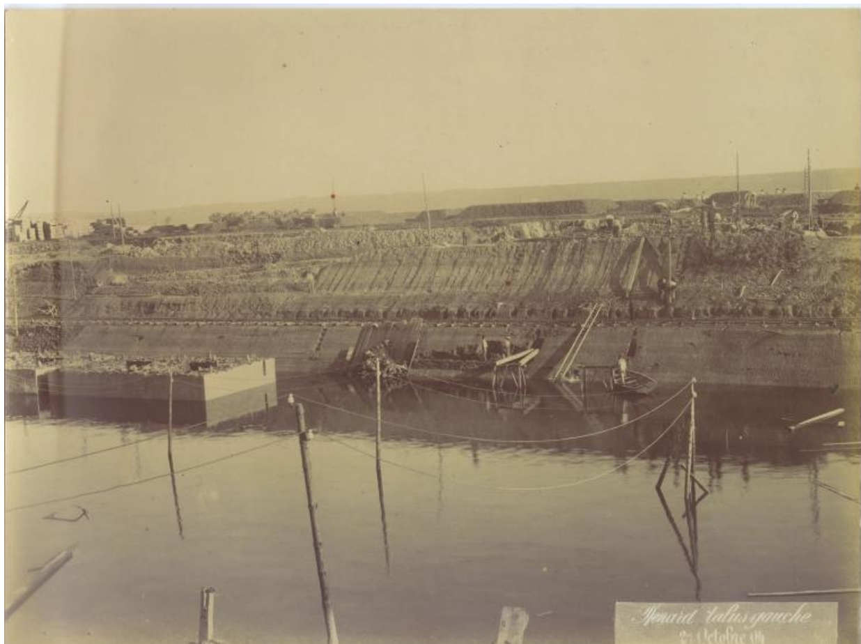
Travaux de la forme de radoub n°1 : inondations du chantier 21 octobre 1904
