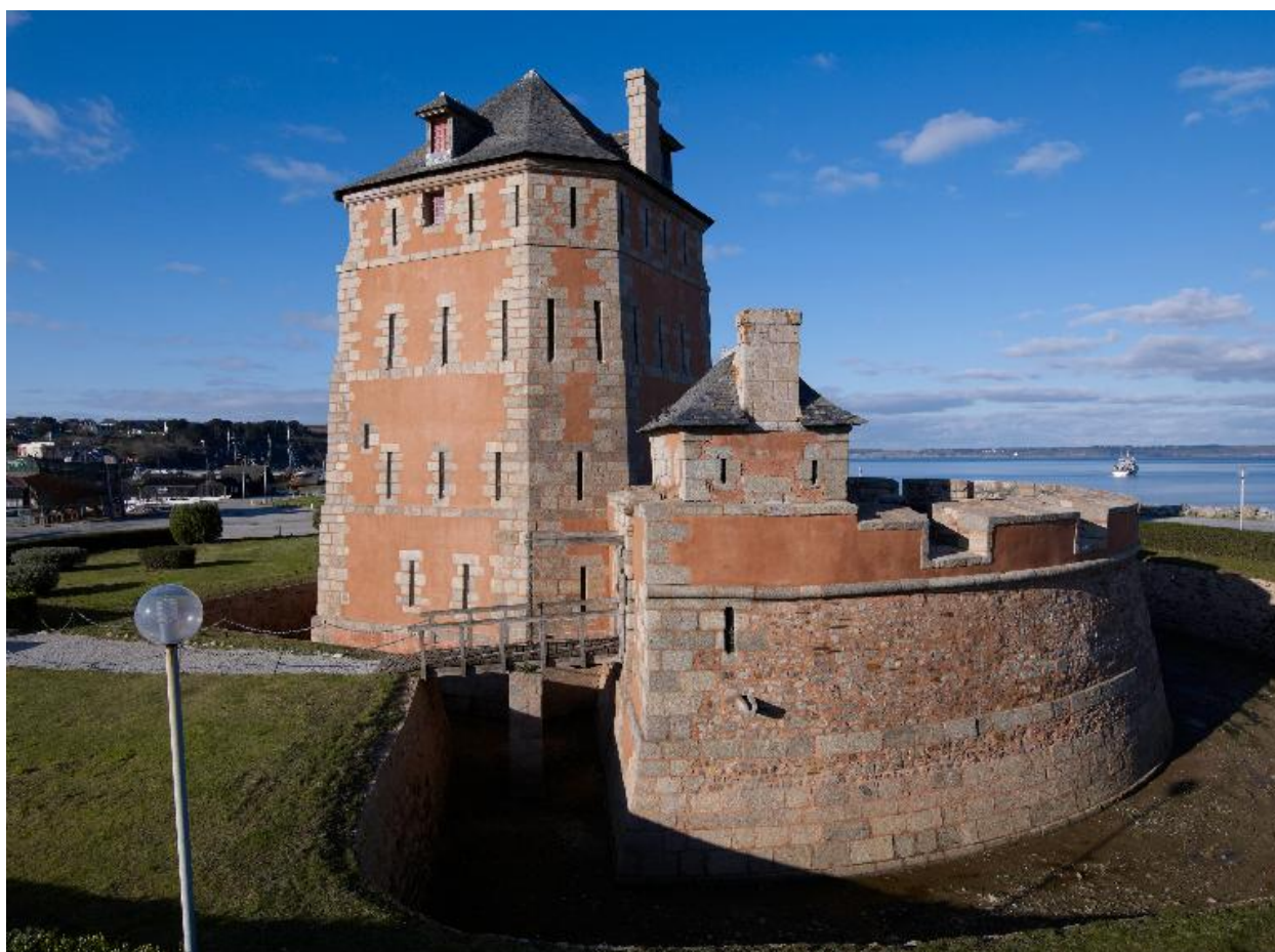
Camaret-sur-Mer : vue de la tour Vauban
