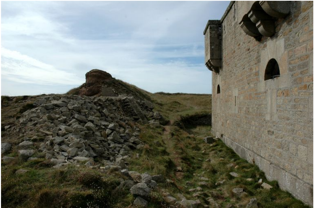
Vue de la batterie de Loqueltas. Emplacement d'une pièce d'artillerie moderne en place lors de la Seconde Guerre Mondiale. Le parapet en maçonnerie est ruiné
