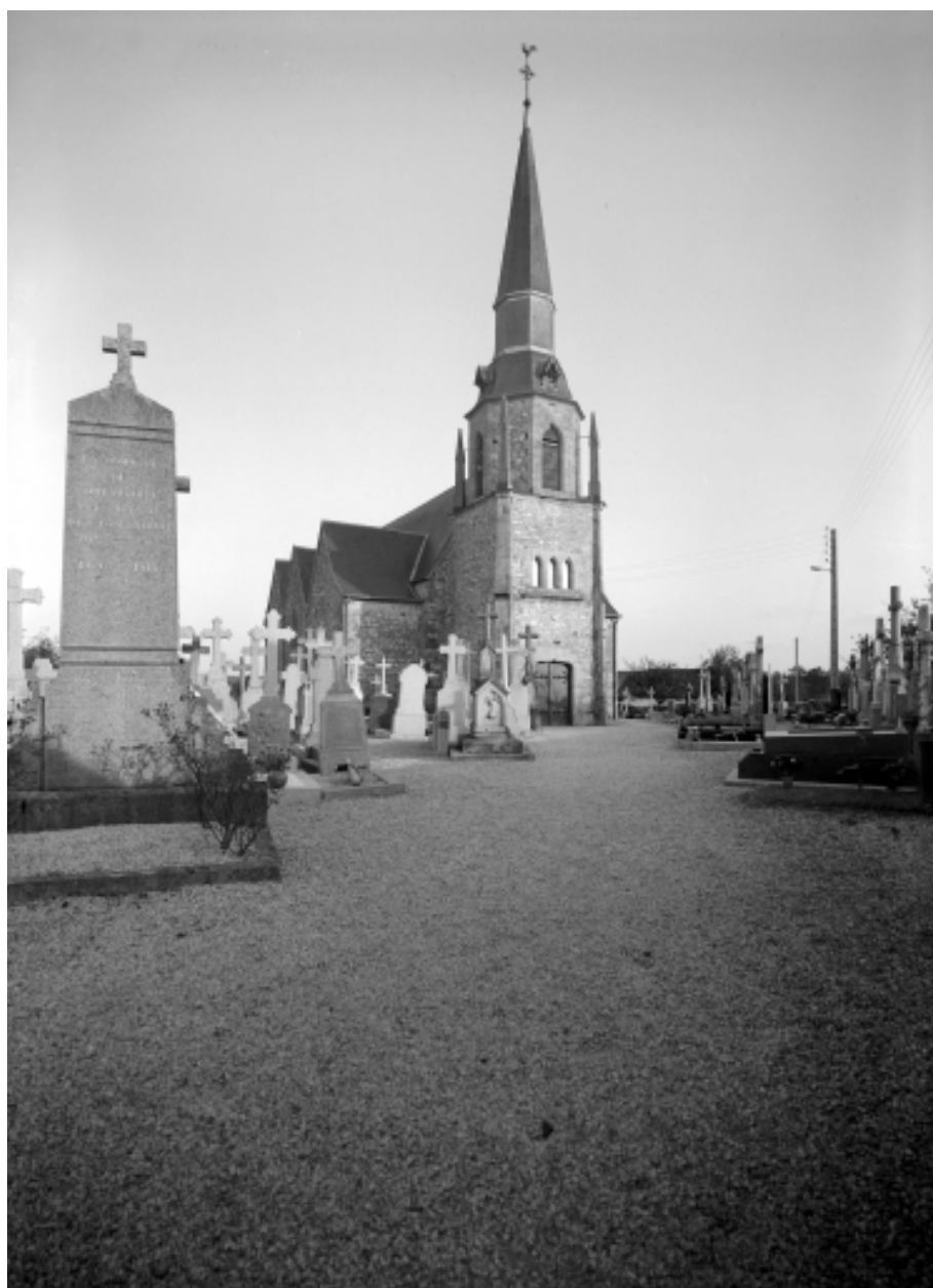
Elévation Sud-Ouest : vue générale
