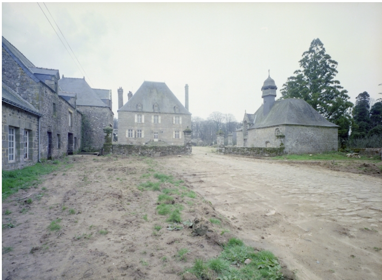
Façade sud : vue générale en 1977
