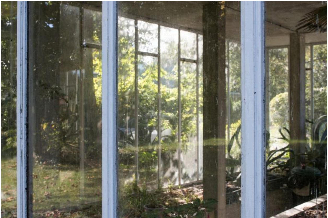
Serre mitoyenne, au sud de la malouinière : détail. Noter la structure en béton.
