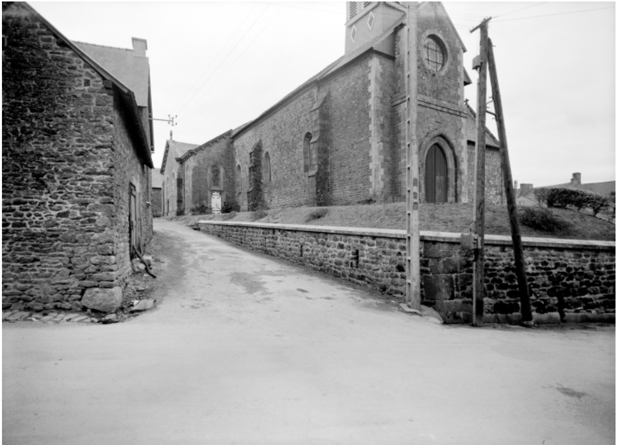
Elévation Nord : vue générale
