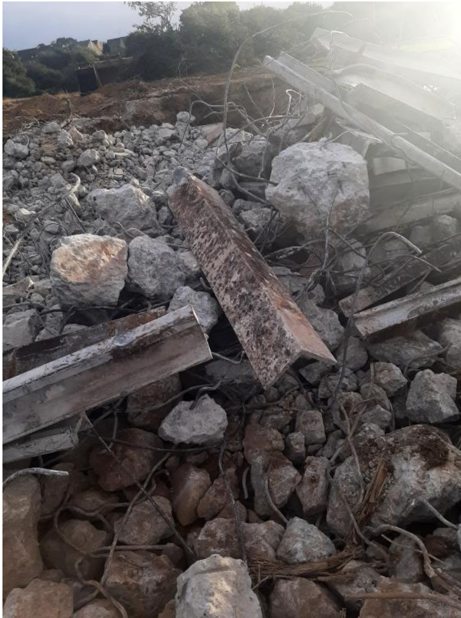
Vue de la déconstruction (26 septembre 2022). Au premier plan : blocs de béton, poutres, fers à béton et rails de chemin de fer
