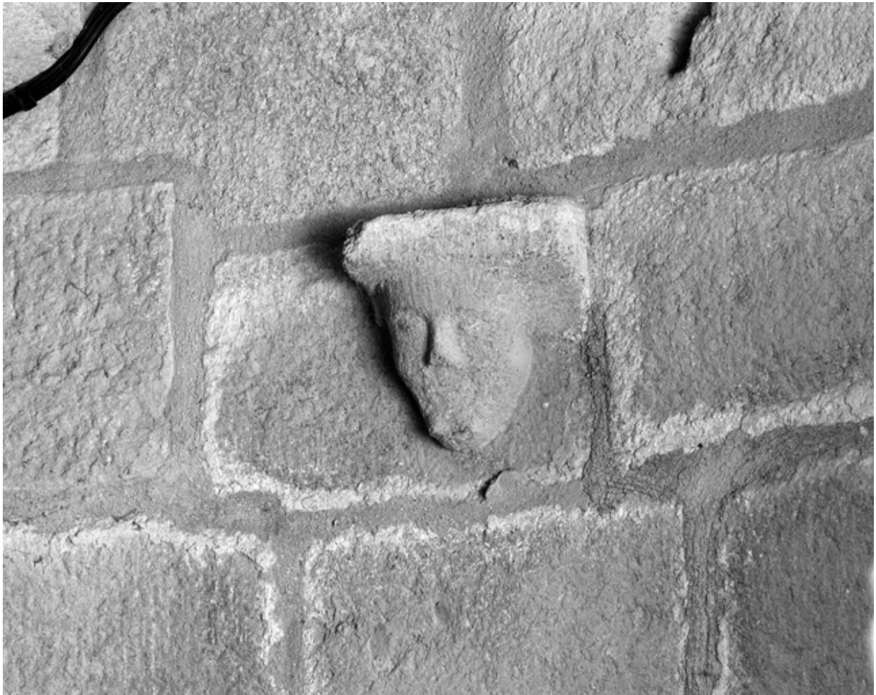
Vue de la tour d'escalier : détail de la tête sculptée intégrée dans le mur au niveau du premier étage (état en 1989)
