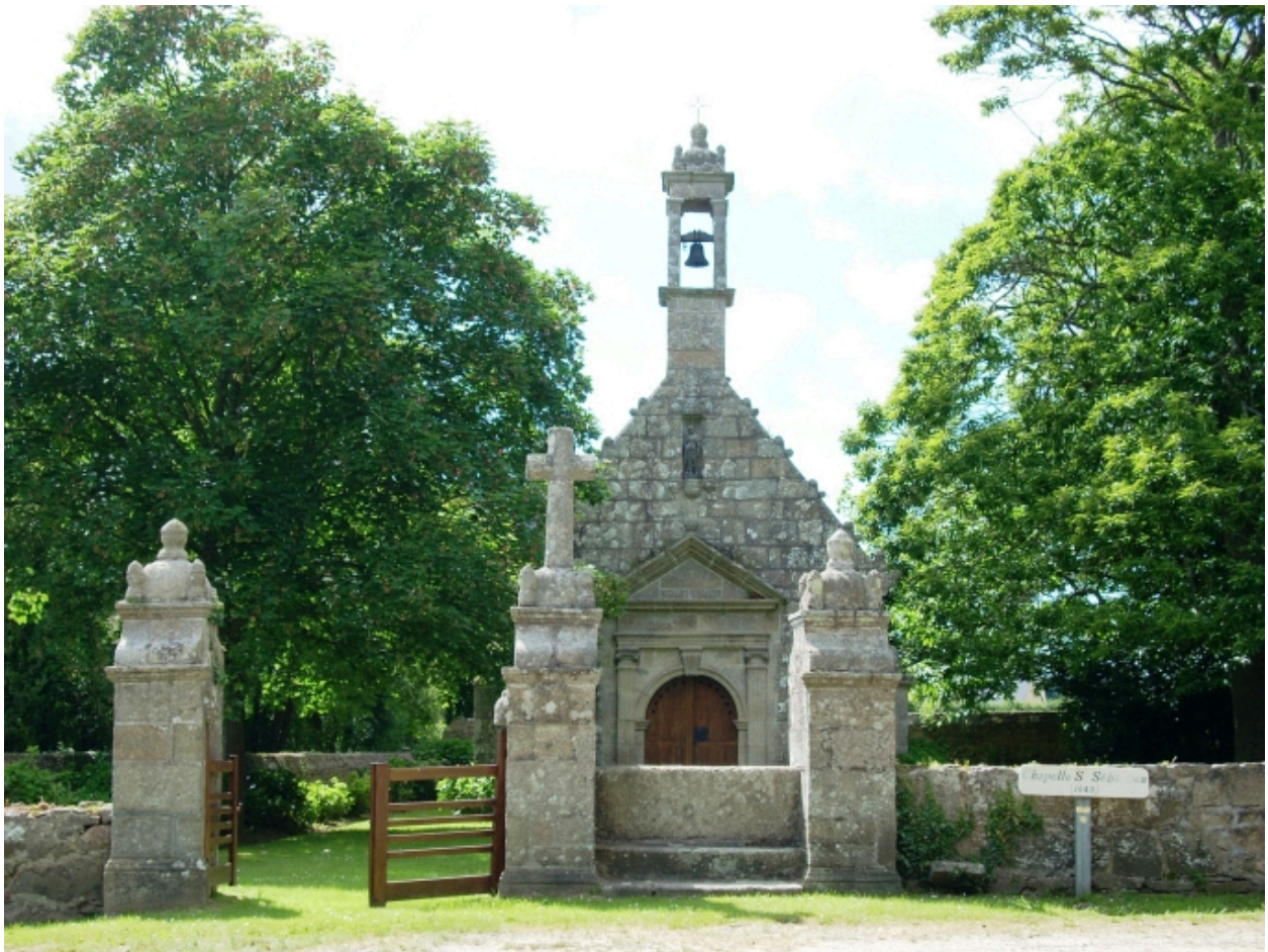
Lannilis, chapelle Saint-Sébastien : vue générale ouest
