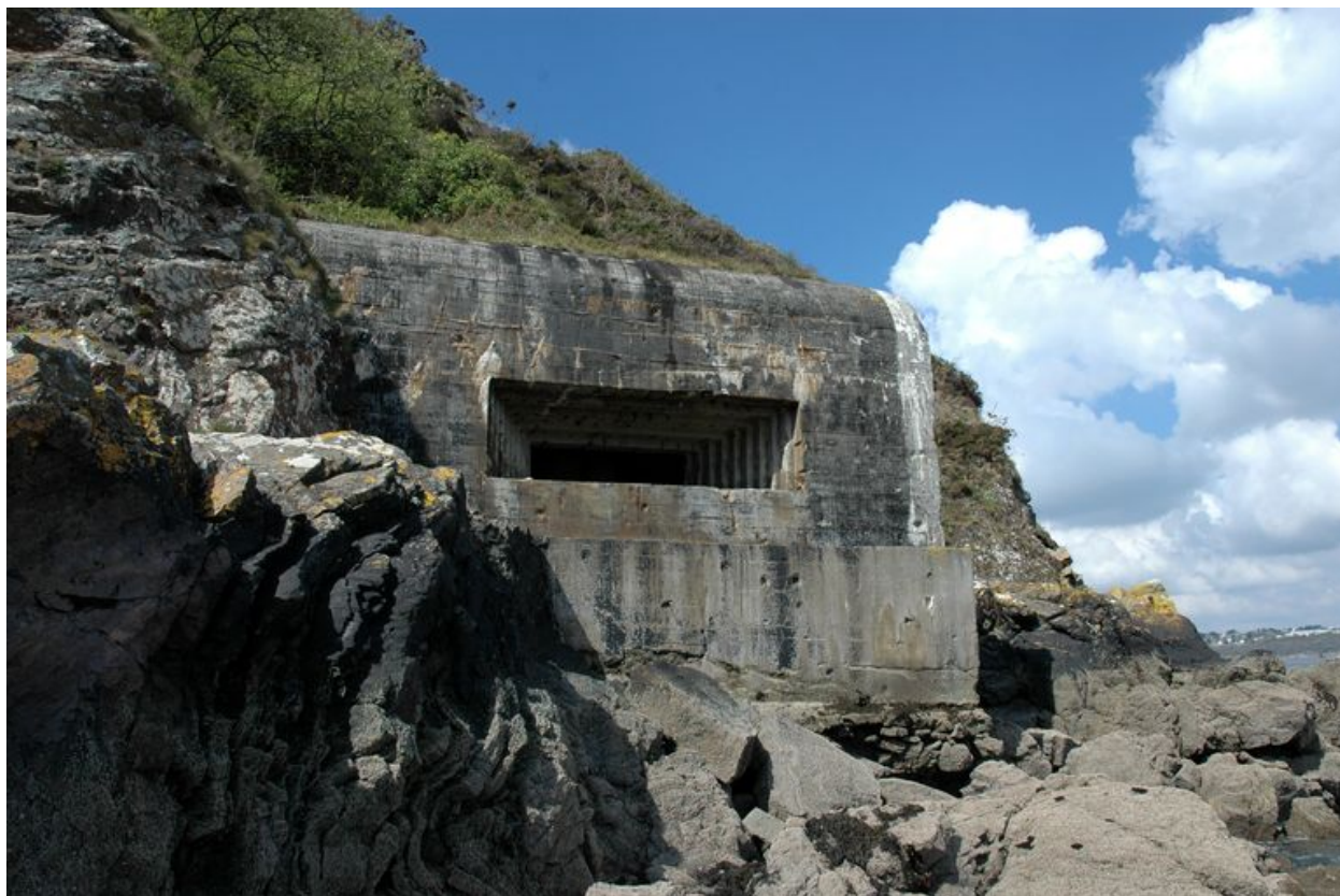
Vue de la casemate orientée vers l'est (état en 2005)
