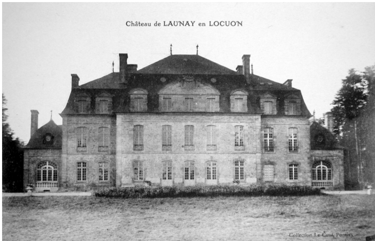
Vue générale après reconstruction (Archives départementales d'Ille-et-Vilaine, 6 Fi Ploërdut)
