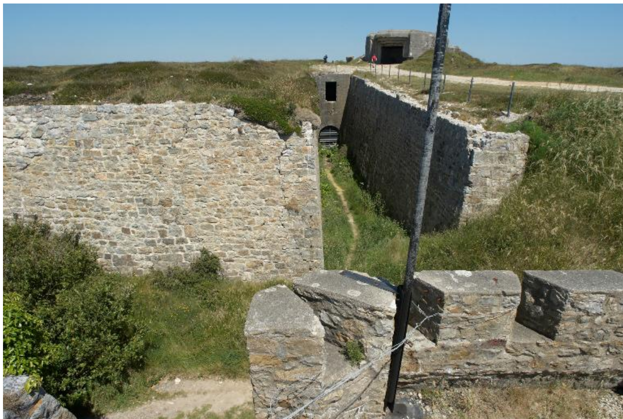
Vue de l'entrée du magasin à poudre sous roc depuis la plate-forme du réduit défensif de la batterie de mortier. En arrière-plan : l'un des trois bunkers - casemates
